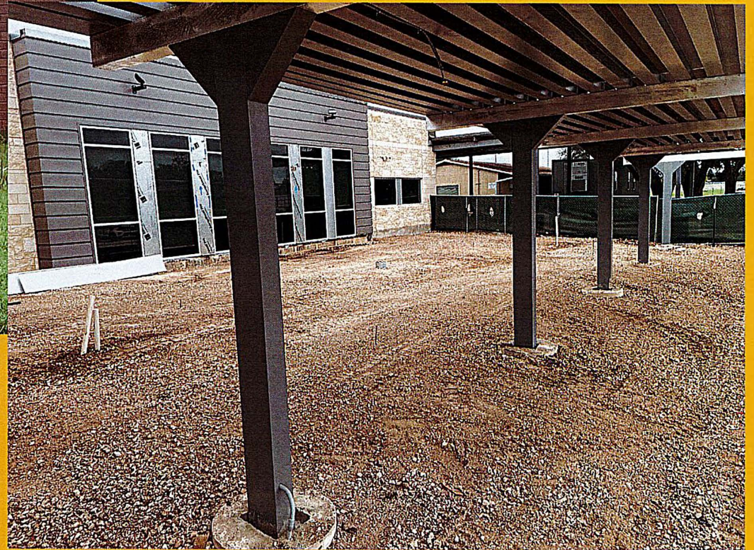
Front drop-off area prepped for concrete pour
