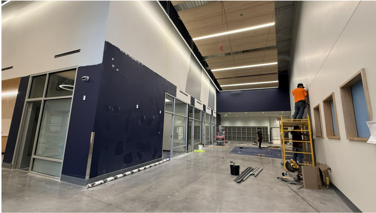
PA WING COMMONS AREA
