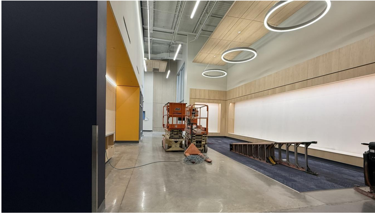
PA WING COMMONS AREA
